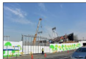
(解体の進む国立競技場)
